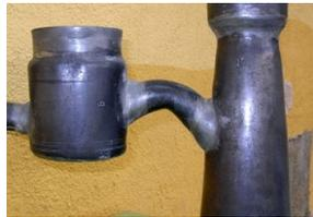
d) La **bajante** es la tubería que baja el agua de los desagües hasta el nivel del suelo. Se conoce vulgarmente como cañería.
