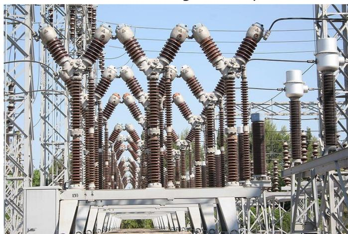
De la gran instalación transformadora la electricidad se traslada a través de las líneas de media tensión a pequeñas subestaciones transformadoras que hay en cada barrio. En estas subestaciones la corriente se transforma nuevamente y pasa a ser corriente de baja tensión, que es la que tenemos en casa (220 V).
